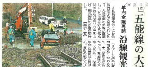
復旧工事が進んでいる五能線の幹線一帯。湯沢駅付近。2月14日午後、五能線沿線の湯沢駅付近。
